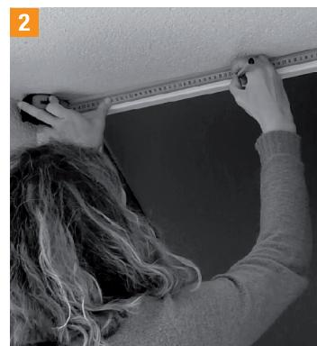
**Misurare la portafinestra (L e H) e riportare le dimensioni sulla zanzariera stesa** / Measure the French window frame (L and H) and mark the size on the mosquito screen / Vermessen Sie die Balkontür (L und H) und übertragen Sie die Abmessungen auf das ausgestreckte Moskitonetz / Mida el ventanal (ancho y altura) y traslade las dimensiones al mosquitero / Mesurer la porte-fenêtre (L et H) et reporter les dimensions sur la moustiquaire étendue.
