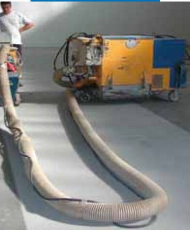
Preparazione del supporto mediante pallinatura
