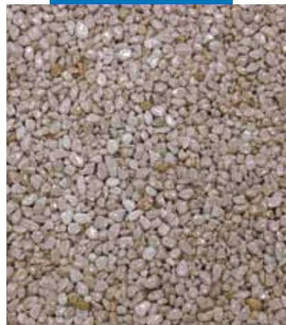
Applicazione della miscela di aggregati naturali + Mapefloor I 910
