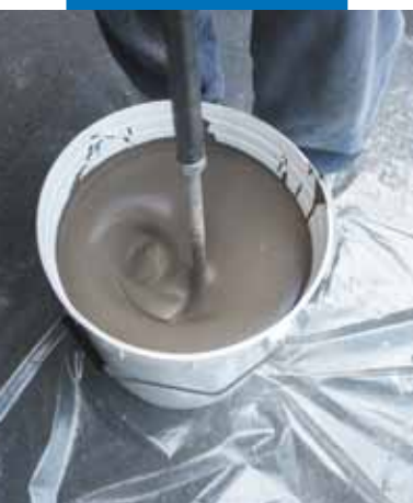
Preparazione del prodotto con trapano
