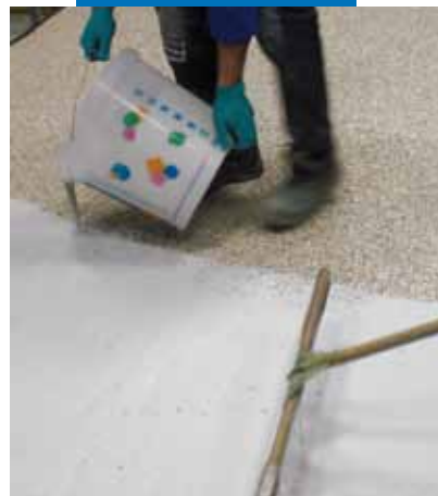
Applicazione di Ultratop sulla superficie indurita eseguita con gli aggregati naturali + Mapefloor I 910
