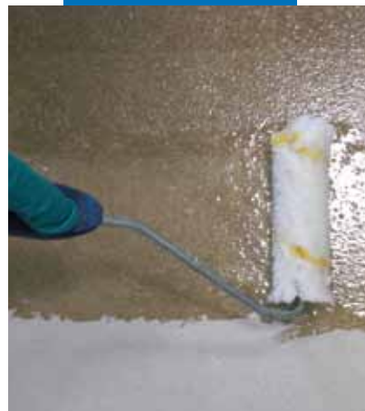
Effetto "Terrazzo alla veneziana" stesura di Mapefloor I 910
