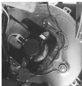
**Sonda temperatura fumi:** questa termocoppia rileva la temperatura dei fumi mantenendo il funzionamento oppure arrestando la caldaia quando la temperatura dei fumi scende sotto il valore preimpostato.
