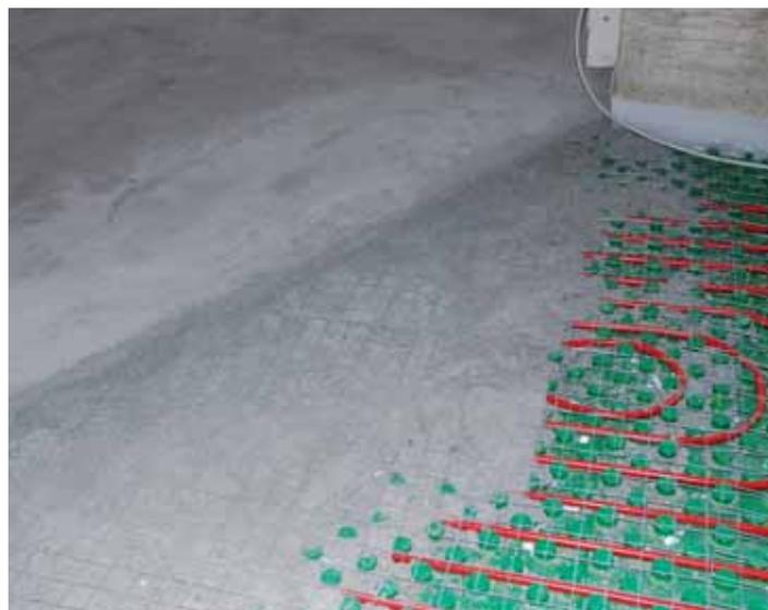
Posa di SUPER SABBIA E CEMENTO FIBRORINFORZATO per la realizzazione di pavimento riscaldato con pannelli radianti.
