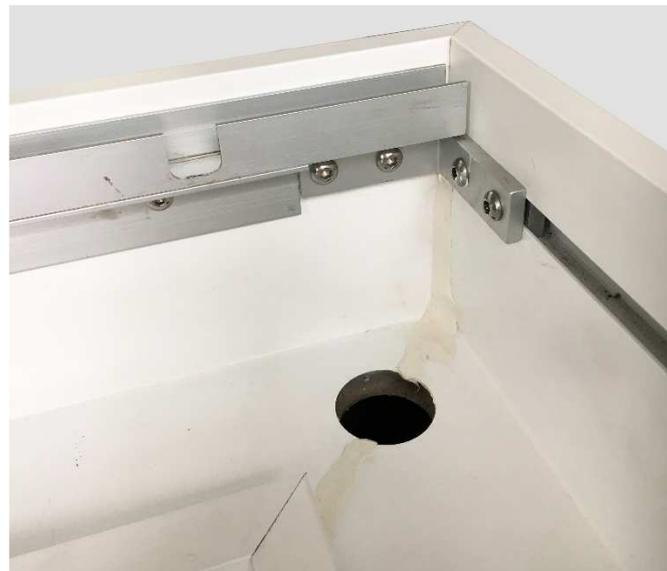
La siliconatura dovrà essere particolarmente accurata sul lato a muro.
